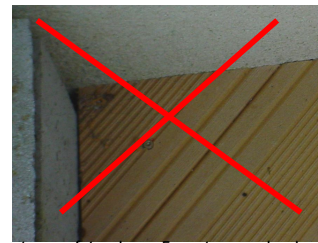
Laat een afstand van 5mm tussen de planken en 15 mm tussen plank en muur.
