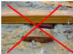
De balken niet inbedden in beton
